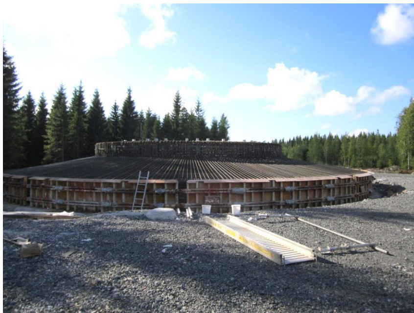
Kuva 94. Kuvassa esimerkki tuulivoimalan perustusten rakentamisesta.
